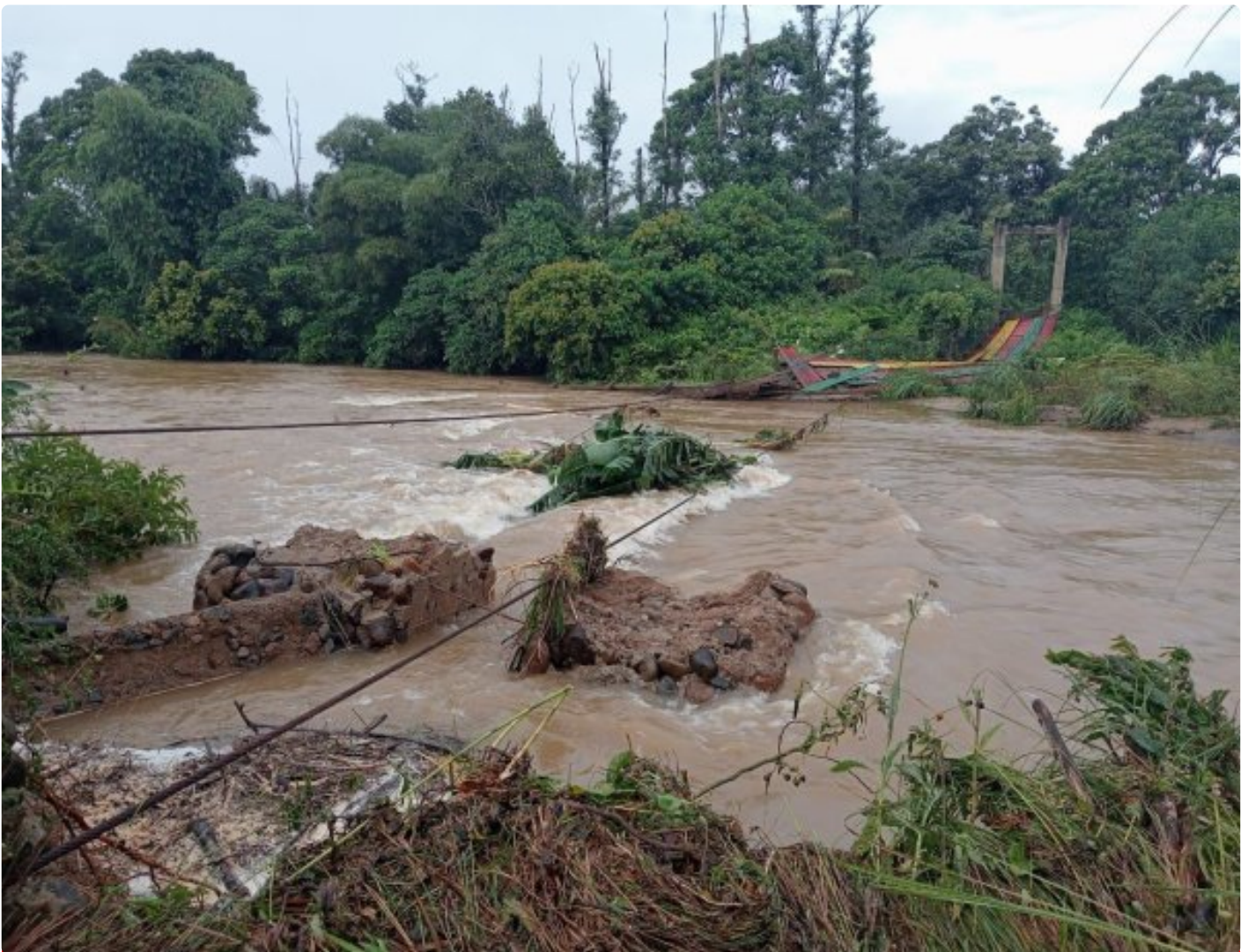
Foto: Jembatan penghubung Ibukota Kecamatan Rampi dan Desa Tedeboe
